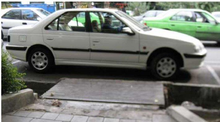
پارک در مقابل پل!
